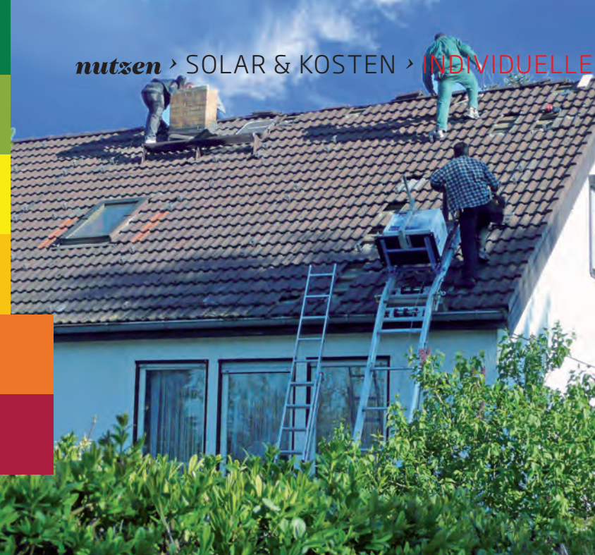
ALLES AUF ANFANG: Der Aufbau der Solar module beginnt.
